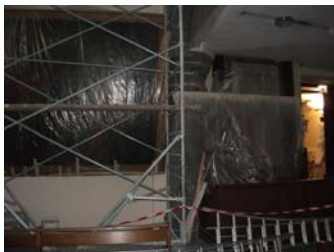
L'église en travaux
